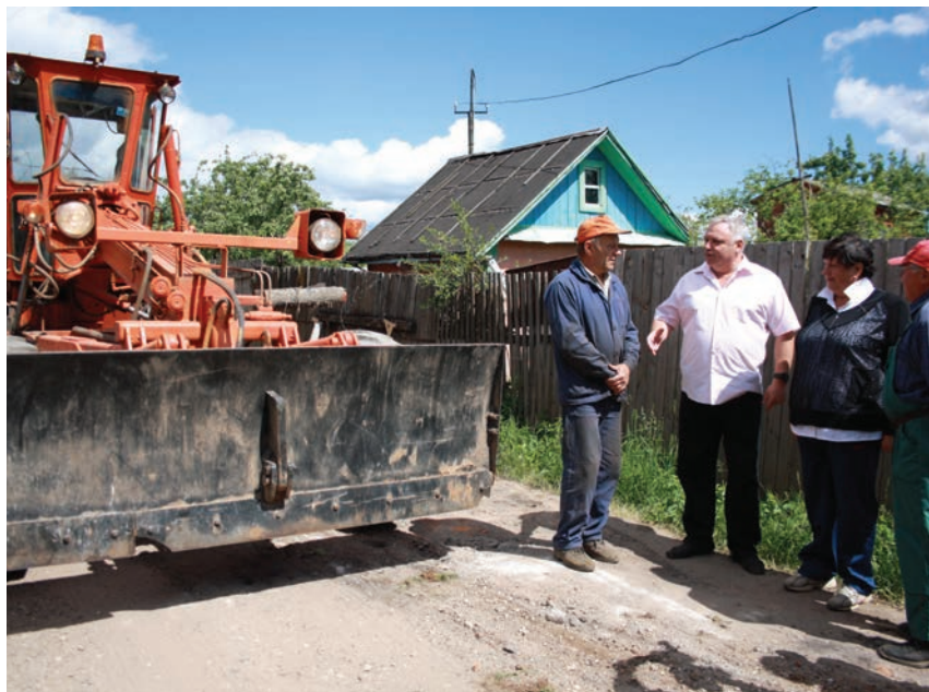
Ремонт дороги под контролем депутата О. Валенчука
